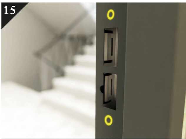
15 Vid säkerhetsdörr: Skruva ut spännskruvarna. Dra inte skruvarna så hårt att karmsidorna bågna eller vrider sig.
