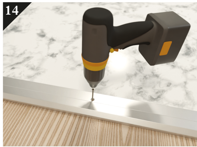
14 Skruva fast tröskeln mot golvet
