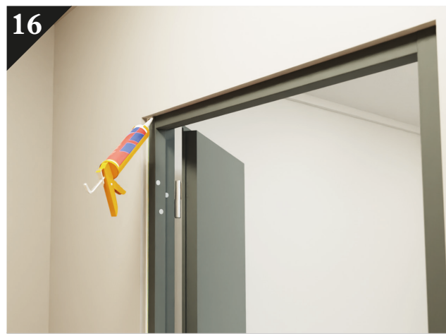
16 Vid rökgasklass och/eller ljudreduktion, foga mellan karm, eventuell väggomfattning och vägg, samt vid tröskeln. Ytterdörrar ska alltid fogas. Se även separat instruktion.
