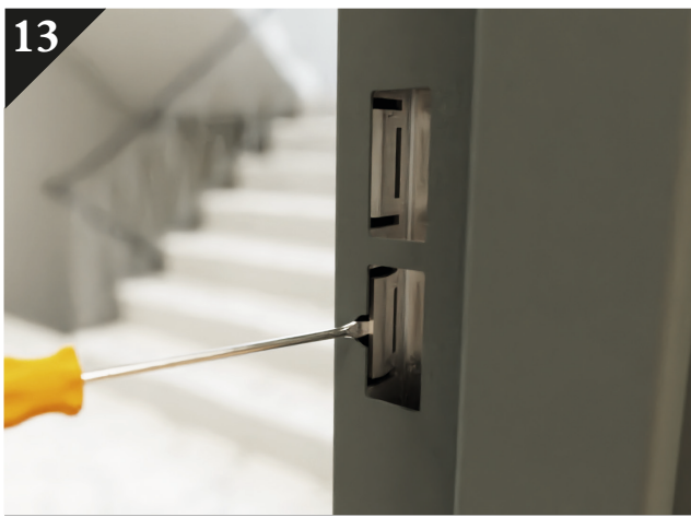
13 Justera slutblecket. Kontrollera spanjoletten alt. kantreglarnas funktion och ingrepp i karm/tröskel.
